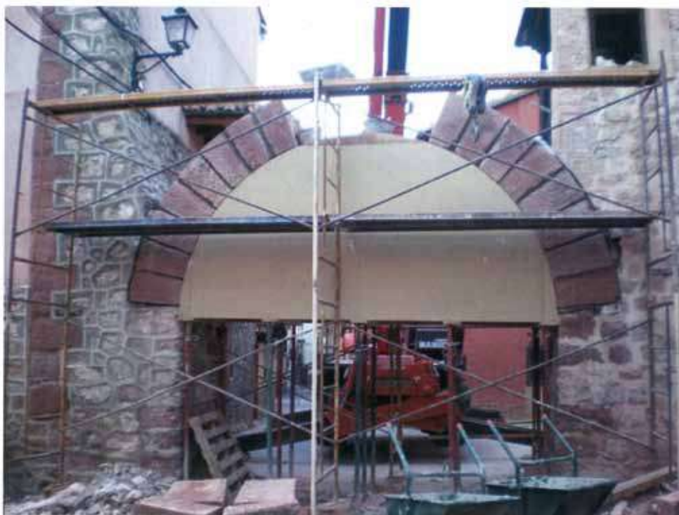
“ RECONSTRUCCIÓN ARCO EN GEA DE ALBARRACÍN - AÑO 2010”
